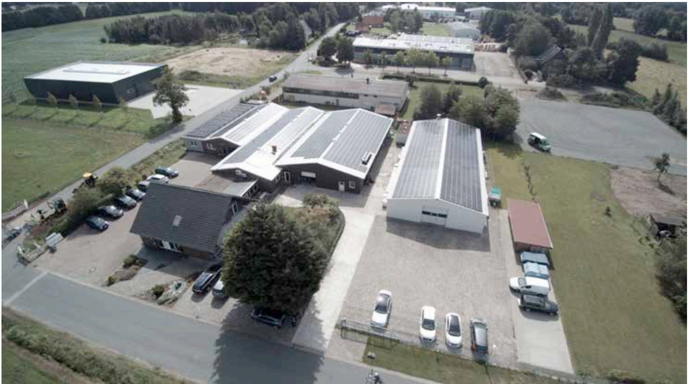
Feilen Pieper aus der Vogelperspektive. Auf der Freifläche hinten rechts entsteht die zweite Photovoltaikanlage. Mit der bereits bestehenden PV-Anlage auf den Hallendächern soll alsbald eine 80-prozentige Autarkie von fossilen Energieträgern erreicht werden.
